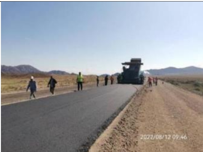
Фото 76. Лот 1. Укладка биндер слоя на км 17+230 - км 17+500.
