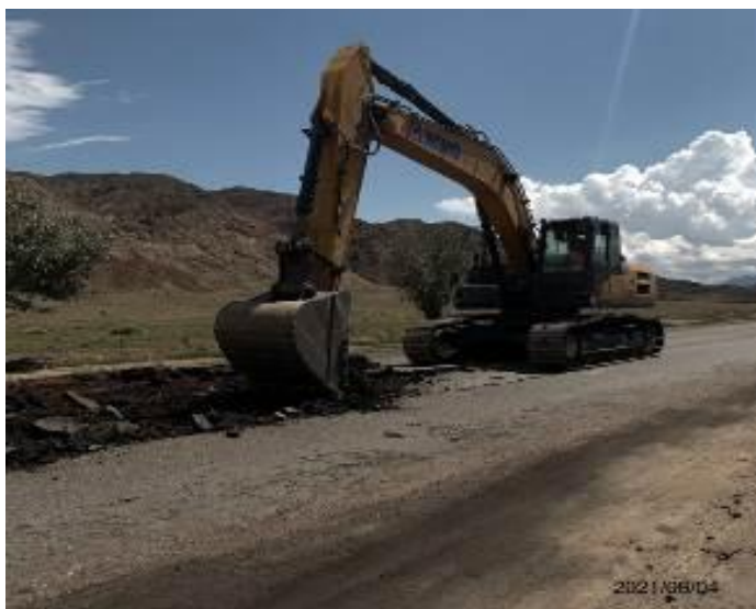
Фото 41. Вскирковка старого асфальта на км. 17+500
