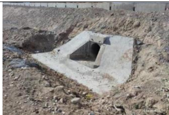
Фото 105. Лот 2. Строительство укрепления на входе трубы, км.88+692
