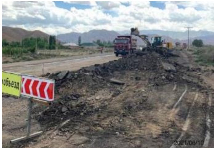
Фото 39. Лот 1. Вскирковка и вывоз старого асфальтобетона на км.7+560 в старый карьер на км 7+100
