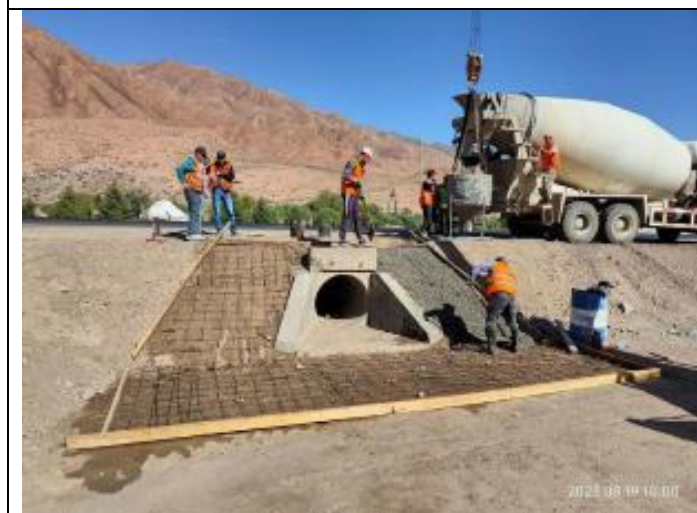
Фото 99. Лот 1. Укрепление входа и выхода бетоном водопропускной трубы на 13+763 BS.
