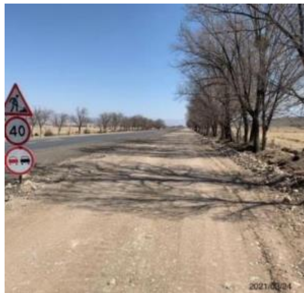
Фото 19 и 20. Обочины дороги с удаленным почвенным слоем
