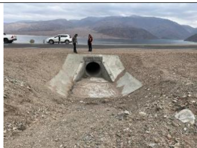
Фото 104. Лот 1. Очистка водопропускной трубы, км 33+869.
