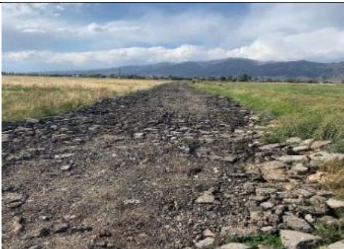
Фото 58, 59. Обустройство периферийной улицы старым асфальтом (укладка и разравнивание) с.Чолпон
