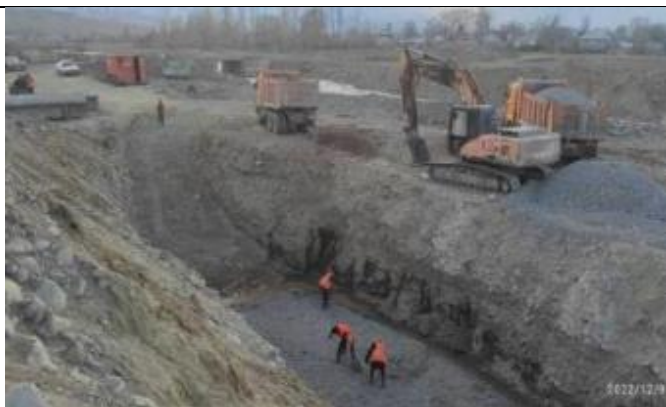
Фото 88. Строительство моста на км 65+410. Устройство основания под фундамент опор моста
