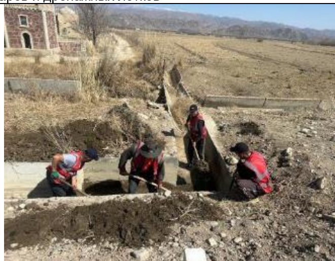
Фото 5, 6. Очистка русла водопропускных труб и бетонных лотков
