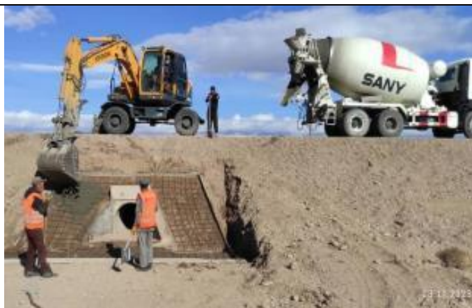
Фото 102. Лот 2. Укрепление откосов на входе водопропускной трубы км 71+800 LHS.
