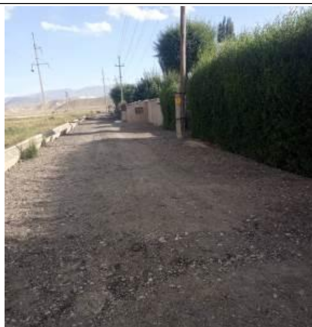
Фото 56, 57. Обустройство периферийной улицы старым асфальтом (укладка и разравнивание) с.Чолпон
