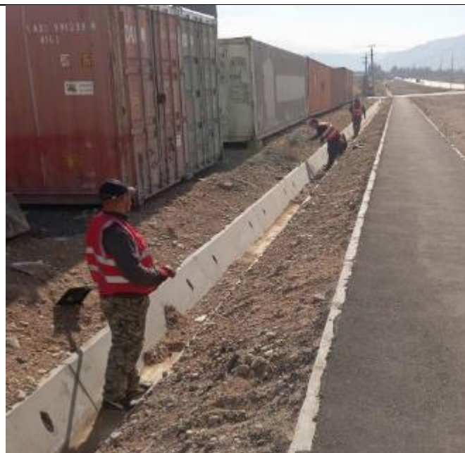
Фото 3, 4. Очистка тротуаров и дренажных лотков
