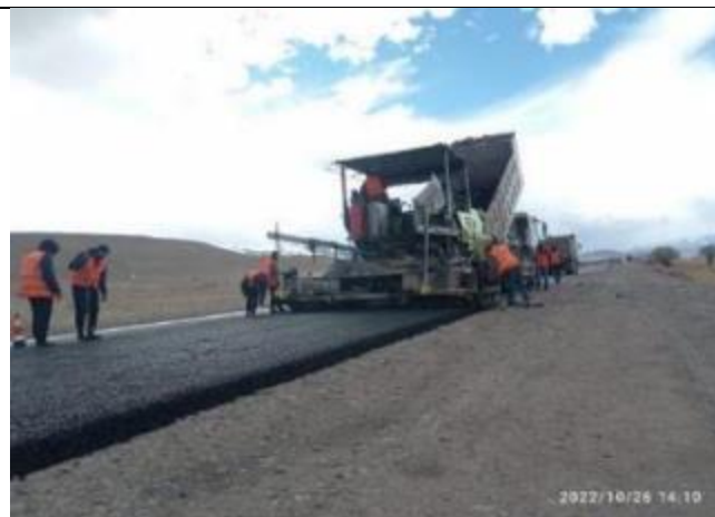
Фото 75. Лот 2. Устройство ЩМА км 81+675-82+000 RHS
