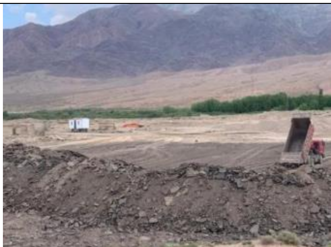
Фото 45. Размещение старого асфальтобетона на км. 7+100. Июль 2021 г.
