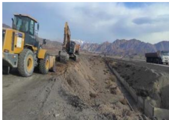
Фото 40. Лот 1. Вскирковка и вывоз асфальта с временных объездных дорог
