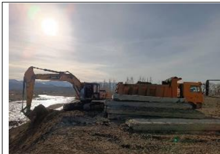
Фото 90. Демонтаж временного моста обьездной дороги на км 62+500 через р. Жоон-Арык
