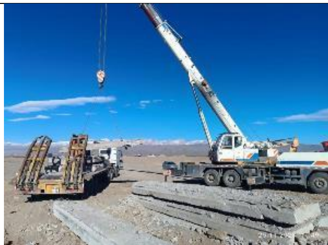
Фото 91. Вывоз демонтированных частей временного моста обьездной дороги на км 62+500
