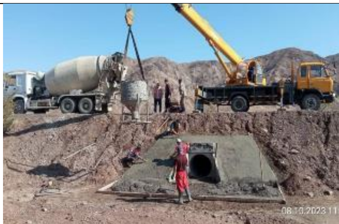
Фото 101. Лот 1. Укрепление входа и выхода бетоном водопропускной трубы на 18+326BS.
