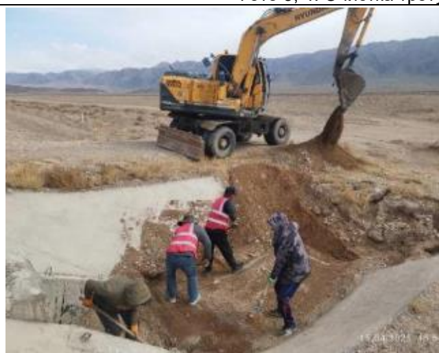
Фото 5, 6. Очистка русла водопропускных труб и бетонных лотков
