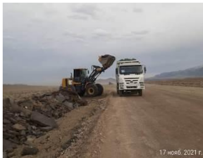
Фото 42. Вскирковка и вывоз старого асфальта на км. 28+200-28+700
