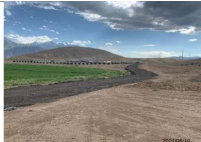
Фото 55. Лот 2. Старый асфальт, для предотвращения пылеобразования, уложен на технологическую грунтовую дорога к ДСУ
