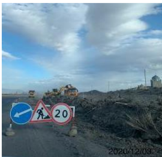
Фото 13. Лот 2. Вывоз ПРС с придорожной полосы на участке км. 83+600 – км. 85+000.
