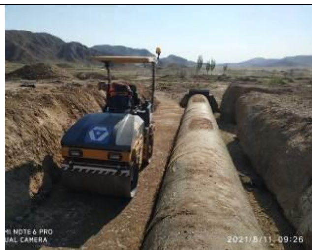
Фото 98. Лот 1. Уплотнение грунта обратной засыпки водопропускной трубы на км 20+670
