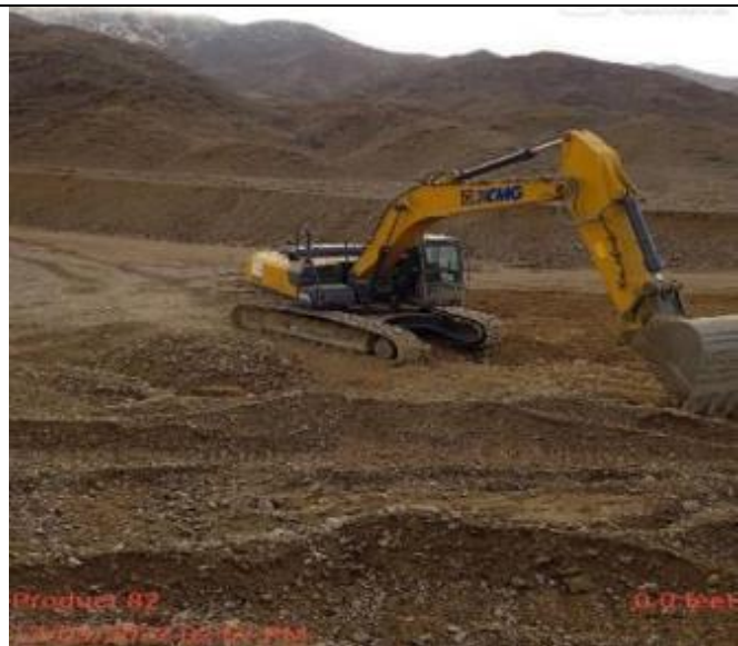
Фото 29. Техническая планировка карьера км 34+240 и приведение откосов борта карьера в безопасное состояние.
