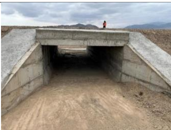
Фото 103. Лот 1, км 22+575, очистка водопропускной трубы.
