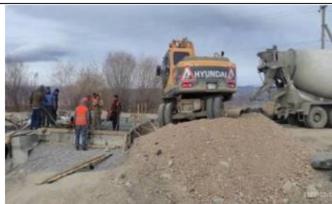
Фото 89. Заливка бетона переходной плиты 1 км 68+044
