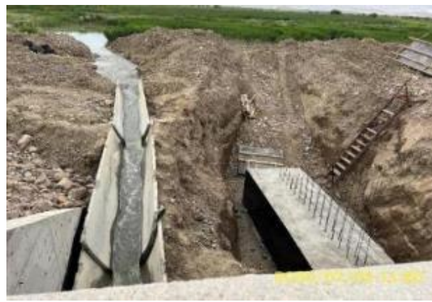
Фото 95. Лот 2. Мост р.Мукандын-Суусу, км. 68+040 Обеспечен отвод воды, предотвращающий попадание грунта в реку, при строительных работах.
