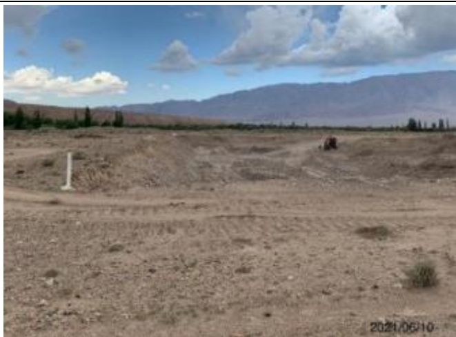
Фото 31. Карьер на км 7+100 справа от трассы дороги, границы карьера отмечены, посредством установки белых стоек.
