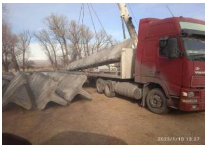
Фото 92. Лот 2. Вывоз демонтированных плит моста на км. 62+400
