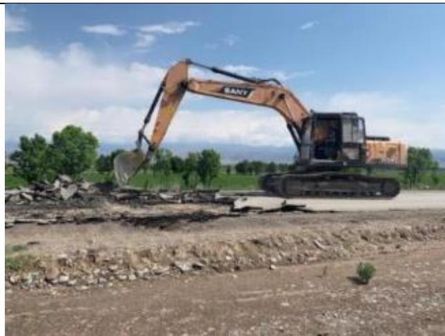
Фото 50. Вскировка асфальтобетонного покрытия на км. 74+550
