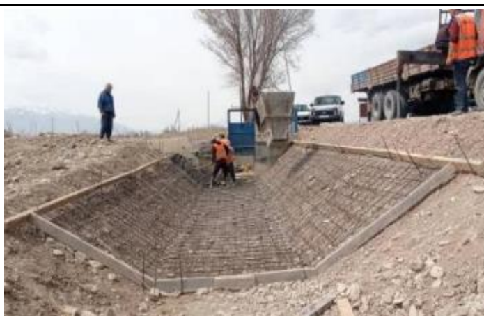
Фото 106. Лот 2. Заливка бетона для укрепления откоса км 64+860.
