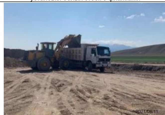
Фото 32. Лот 1. ПРС снят с участка под карьер км.9+000, отмечены границы карьера, посредством установки белых стоек с флажками
